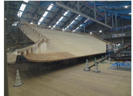
素屋根工事状況：2年後に完成予定
